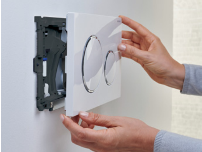
1 Desloque a placa de descarga lateralmente.
