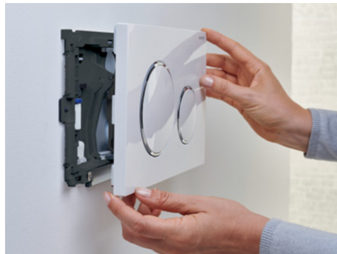
1 Desloque a placa de descarga lateralmente.
