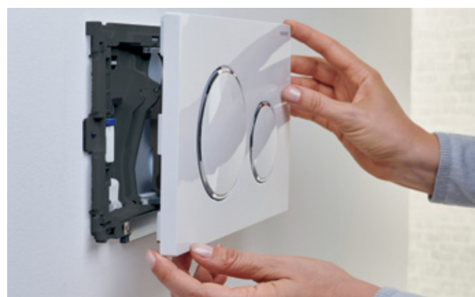
1 Desloque a placa de descarga lateralmente.
