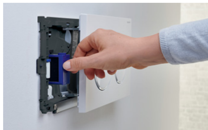
3 Volte a colocar a placa de descarga. O stick já está num sítio fixo dentro da água do autoclismo.
