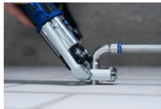
↑ Para Geberit Mapress até d35, os colares de compressão e as mandíbulas adaptadoras são ideais para espaços reduzidos. O colar de compressão compacto é posicionado e comprimido de forma segura através da mandíbula, que pode rodar até 180°.
